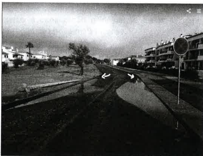
Foto 2 – Colocação das grelhas dos sumidouros fora da zona de acumulação de água, nova perspectiva
