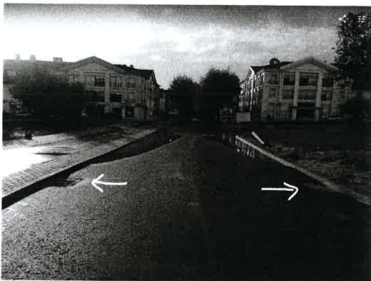
Foto 1 – Colocação das grelhas dos sumidouros fora da zona de acumulação de água
